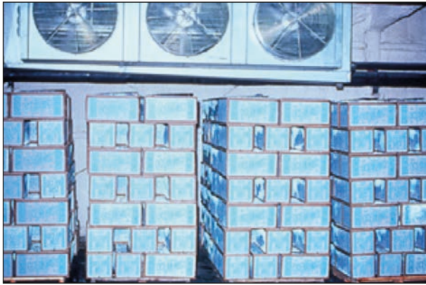
Şekil 7. Odada önsoğutma çalışma prensibi, seyrek istifli yerleşim. [5, 13].
