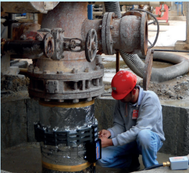
Şekil 4. Frekans tekniği ile ısı eşanjörünün kireç'ten korunması
