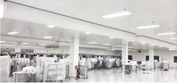
Resim 2. Türkiye'de bulunan Temiz oda ISO Class 3 standartlarını izlendiği farmasötik tesiste tekstil kanal uygulaması
