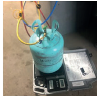
Şekil 1. Soğutkan yüklemesinin terazi ile yapılması
