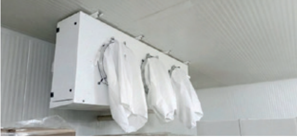
Şekil 5. Kumaş defrost kanalının soğuk depo uygulamasındaki görünümü [7].
