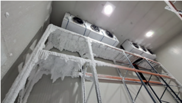
Şekil 1. Soğuk hava deposunda karlanma.
