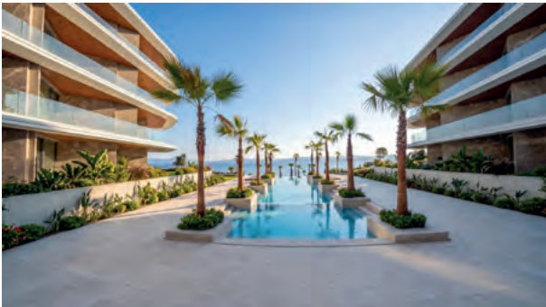
Öge Mühendislik, mekanik tesisat alanındaki deneyimiyle villa ve konut projelerinde de mühendislik çözümleri sunuyor.
