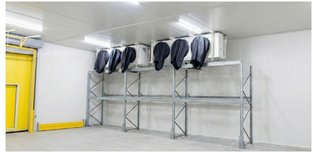
Şekil 3. Kumaş defrost kanalının defrost modundaki görünümü [7].
