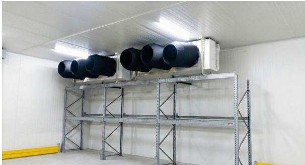
Şekil 2. Kumaş defrost kanalının soğutma modundaki görünümü [7].
