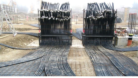
Şekil.5-Kazık başlarından toplanan enerji boru demetleri
