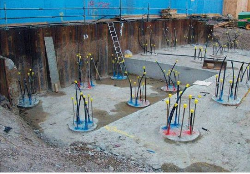
Şekil.3-Temel altına uygulanan enerji kazıkları
