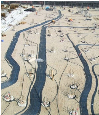
Şekil.4-Enerji kazık başlarından PE boruların kolektöre toplanması
