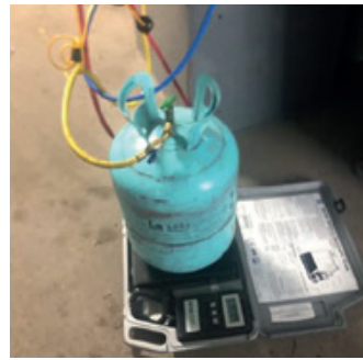
Şekil 1. Soğutkan yüklemesinin terazi ile yapılması
